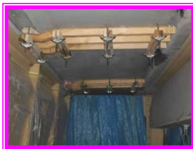
接合部型枠設置
