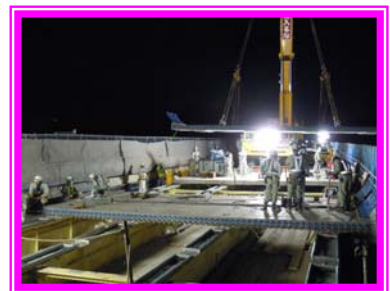
SLJスラブ架設
