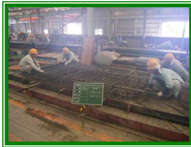
PC鋼材挿入
