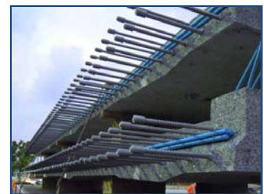
【橋軸直角方向鉄筋配置状況】
