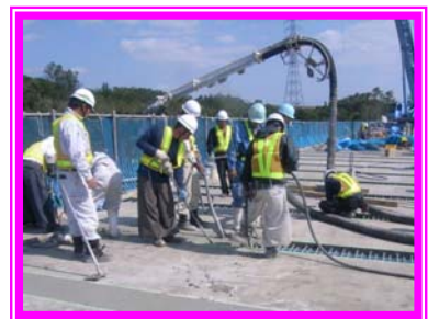
コンクリート打設
