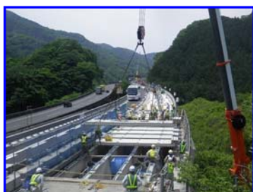
SLJ スラブ架設
