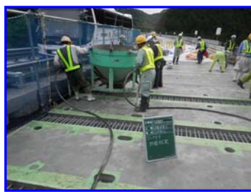
ドライミックス方式速硬性 コンクリート打設
