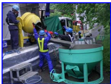
ドライミックス方式速硬性 コンクリート練混ぜ
